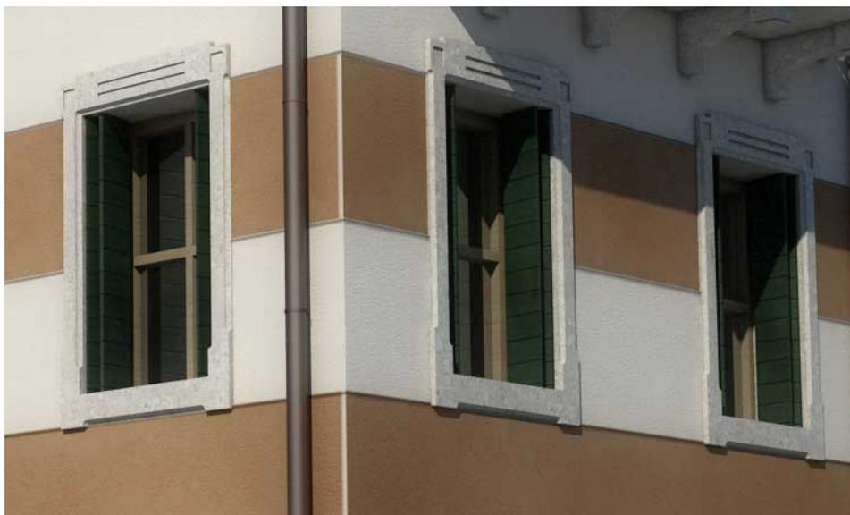
Dettaglio del disegno caratteristico dei profili originari dei fori finestra, riprodotti nel Fabbricato A
